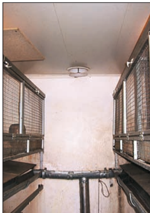
Бокс для содержания молодняка птицы оборудован принудительной приточно-вытяжной вентиляцией
